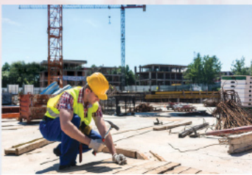
ไซต์งานก่อสร้าง
